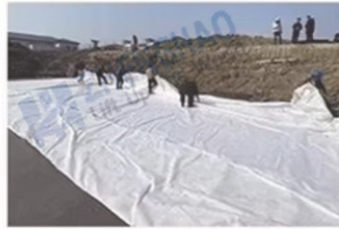
Step 3: Laying Geomembrane
