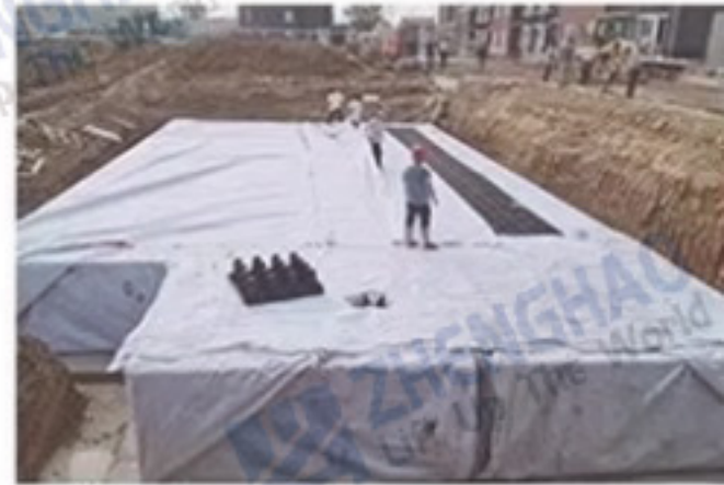
Step 6: Geomembrane wrapping
