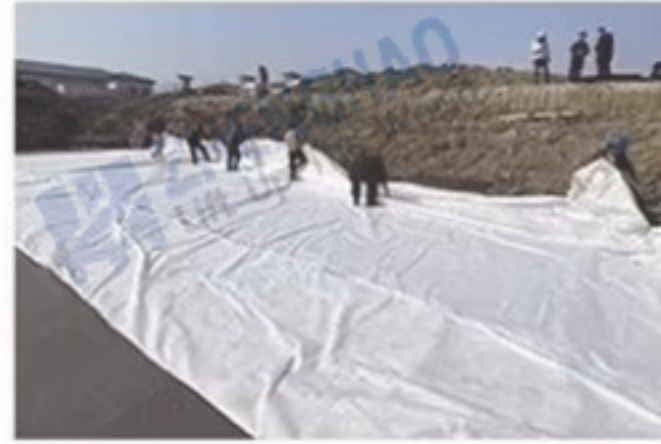
Step 3: Laying Geomembrane
